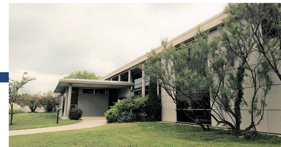
ENTREPÔTS . A VENDRE . A LOUER 4 428 m 2 non divisibles BALMA (31130)
