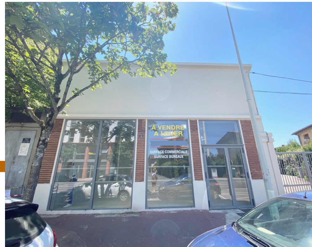
LOCAL COMMERCIAL . A VENDRE . A LOUER 368 m 2 divisibles dès 178 m 2 MONTAUBAN (82000)
