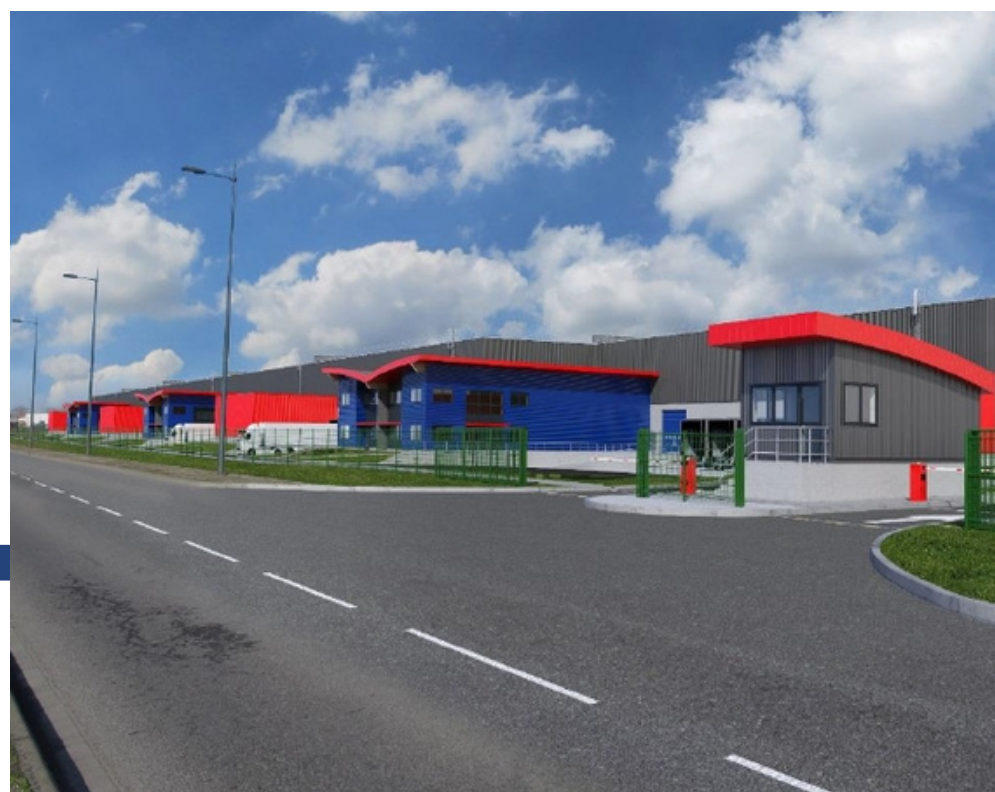
ENTREPÔTS LOGISTIQUES . A LOUER 23 905 m 2 divisibles dès 4 870 m 2 CASTELNAU D'ESTRETEFONDS (31620)
