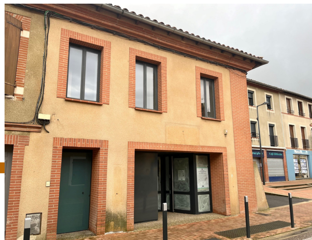
LOCAL COMMERCIAL / PROFESSIONNEL A VENDRE / A LOUER 225 m 2 non divisibles PLAISANCE DU TOUCH (31830)
